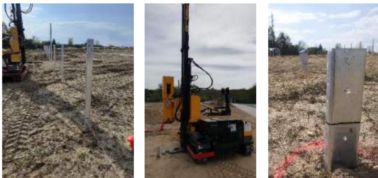
Illustration 3 - Ancrage au sol par pieux battus (source : Solarvia)
