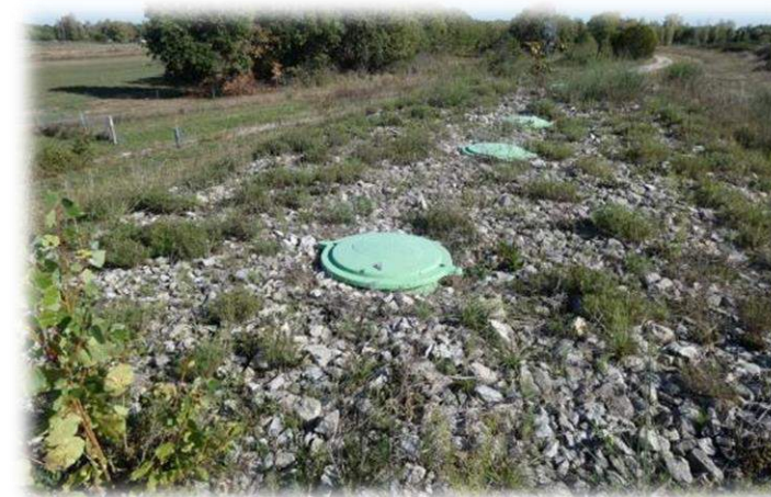
Regards implantés sur le système d'assainissement des eaux usées de l'AEI
