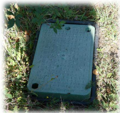
Regard de réseau d'eau potable observé sur la frange nord de l'AEI, à proximité du poste électrique
