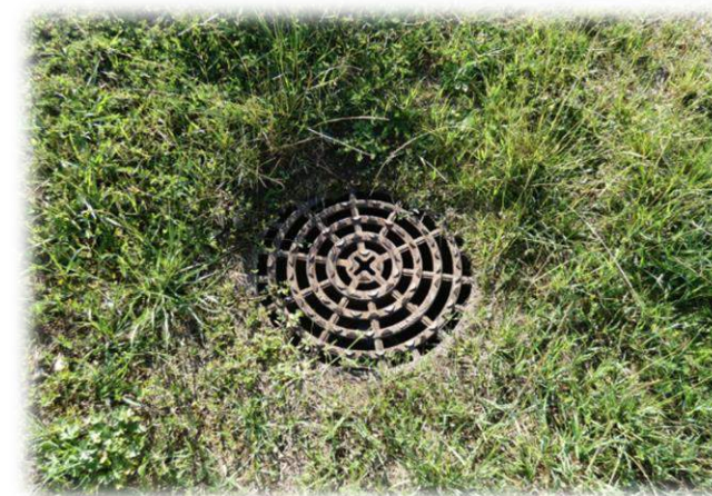
Bouche de collecte des eaux pluviales observée sur site
